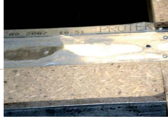
Horpadás a koszorúprofil gerinclemezeiben
